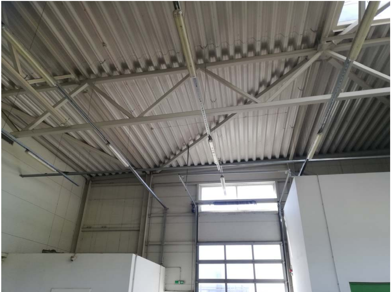
306 pav. Statinio 3F1g stogo konstrukcijų fotografacija
