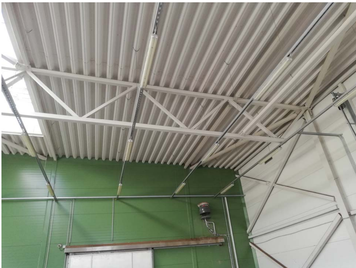
304 pav. Statinio 3F1g stogo konstrukcijų fotografacija
