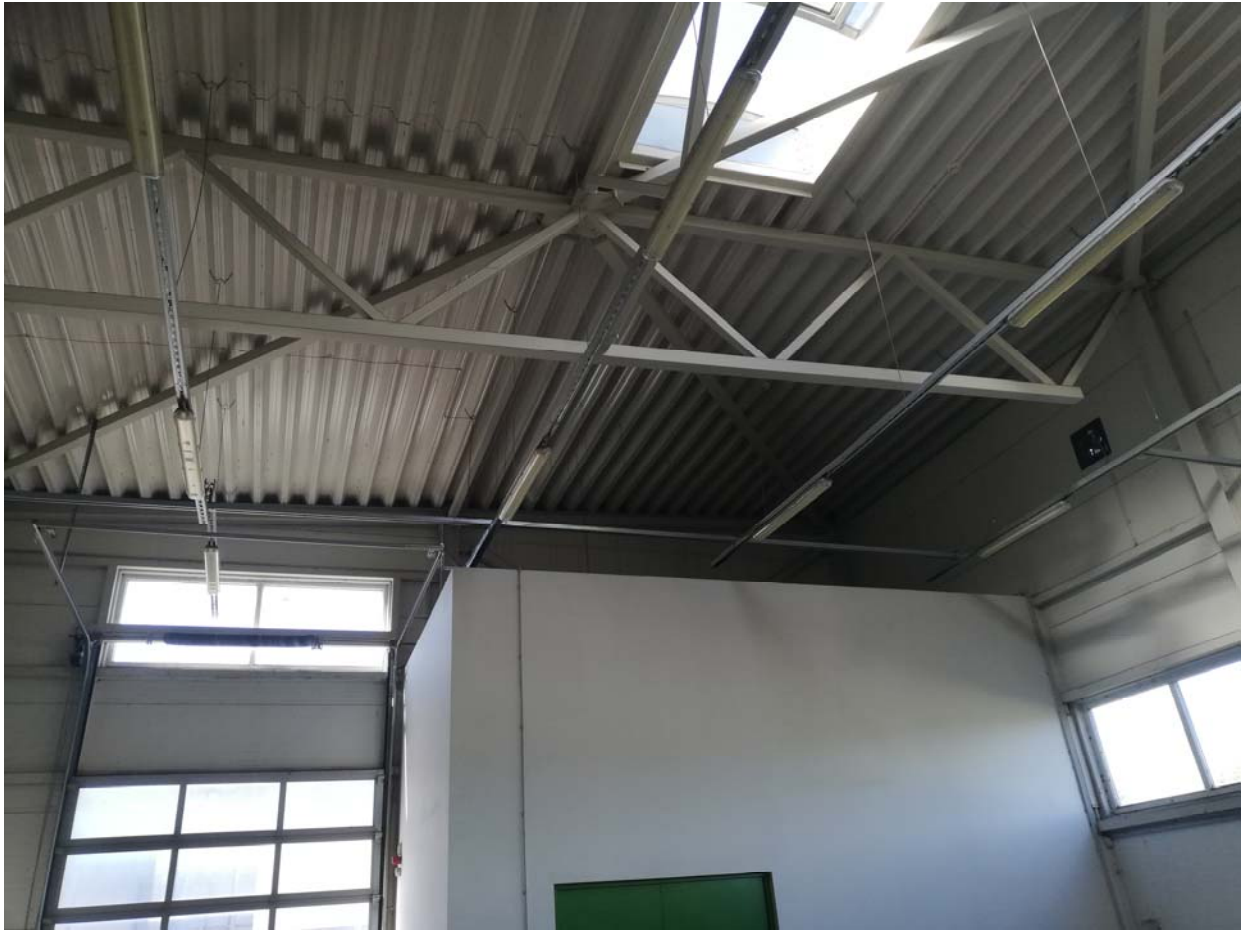
305 pav. Statinio 3F1g stogo konstrukcijų fotografacija
