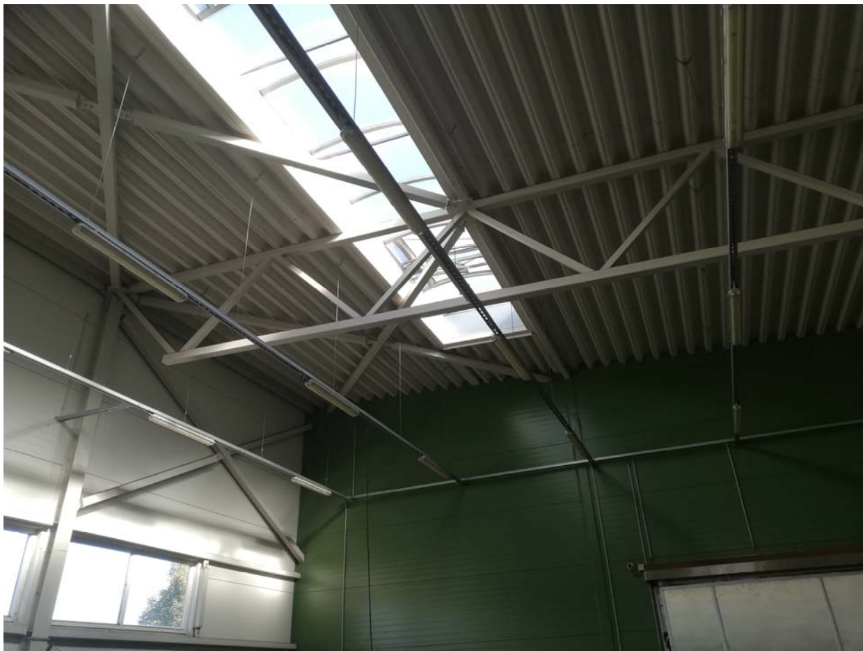
303 pav. Statinio 3F1g stogo konstrukcijų fotografacija
